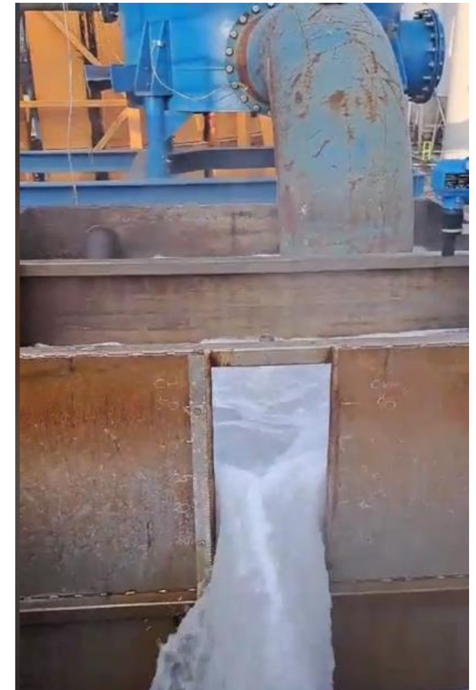
Test der Bohrung Gt Nn 4/23 Neuruppin
